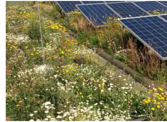
Biodiverse green roof
